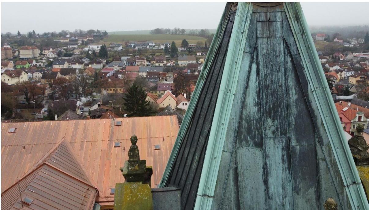
Měděné oplechování nároží, napojení
