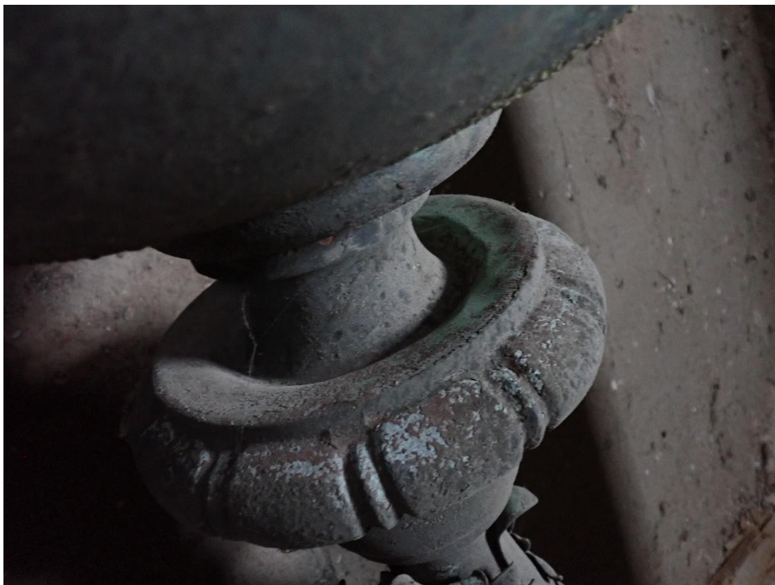
zinkový odlitek na hrotnici opatřený barvo
