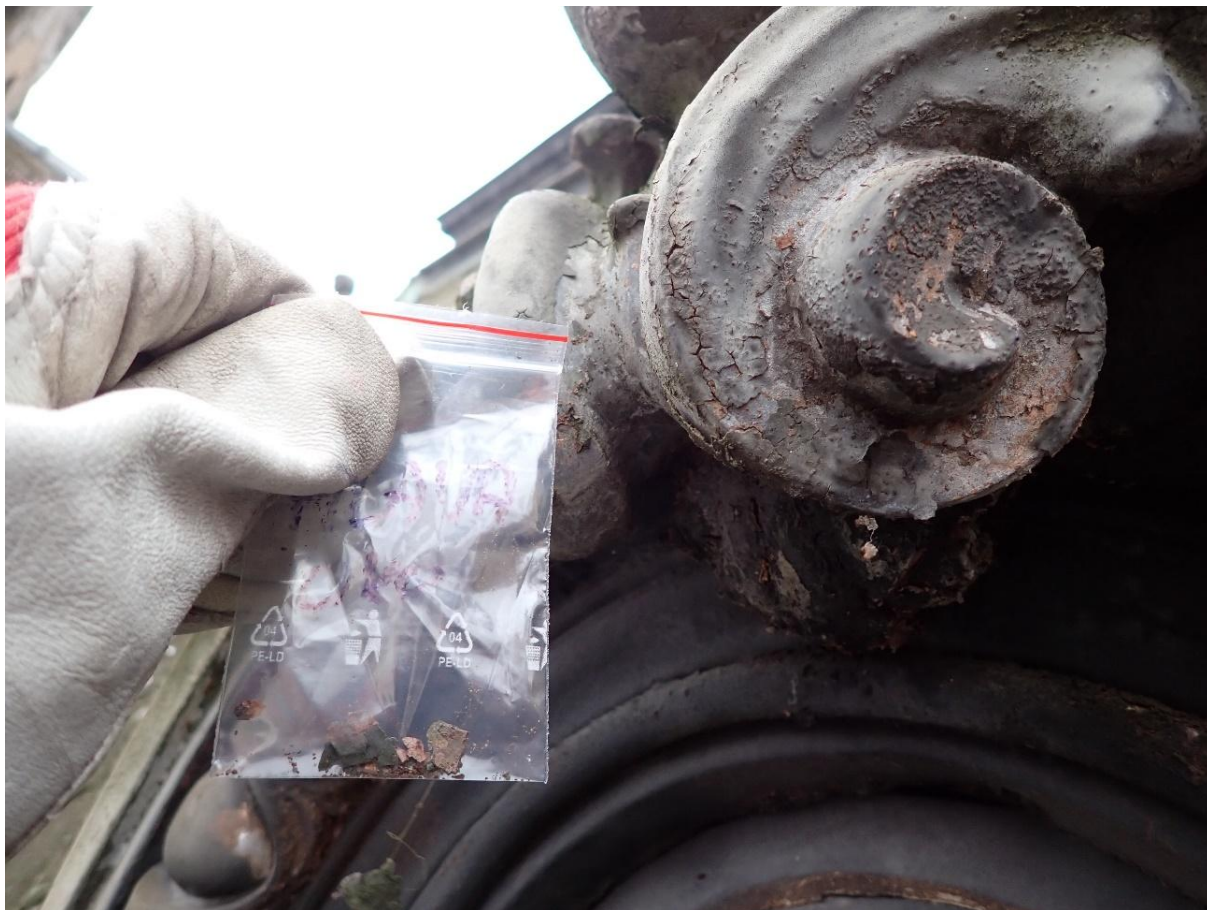
Degradace povrchové úpravy – odebrání vzorku pro stratigrafie
