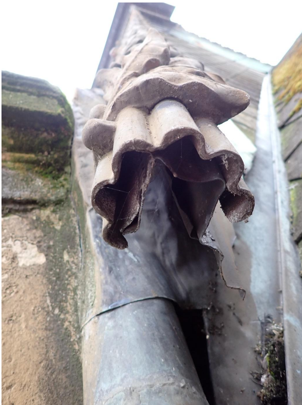
Zinková litá lišta naložená na měděné liště
