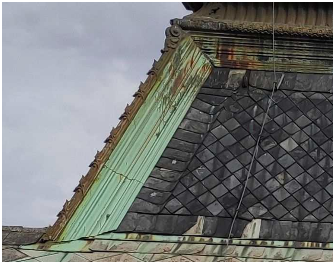
Pohled na kompletní lištu-oplechování, včetně zinkové výzdoby.
