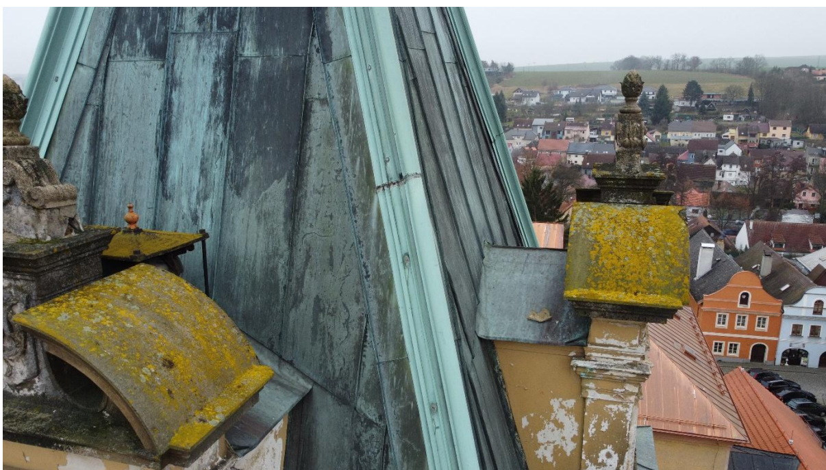
Měděné oplechování nároží, napojení
