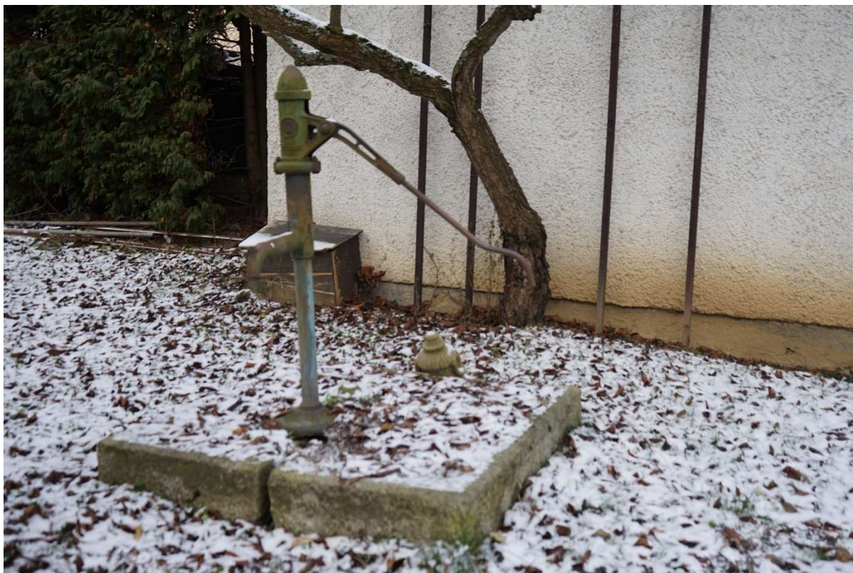
Obrázek 4 Stávající studna na pozemku na pozemku p.č. 875, hl. 12,5 m, hladina k 20.12.2022 7,5 m p.t.
