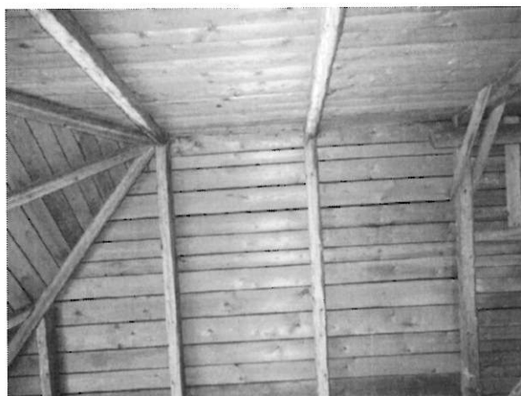
č. 14 Detail konstrukce krovu a podbití střešního pláště
