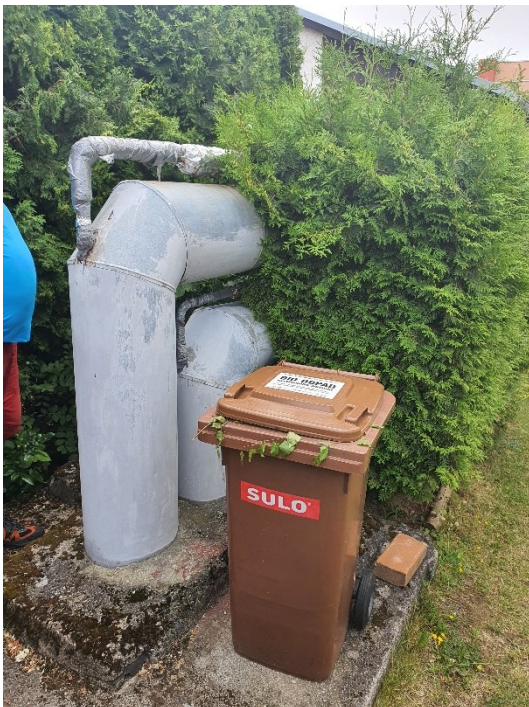
Foto 13 - potrubí propoje NTK Kovařovicova – VS Palackého vystupující nad terén
