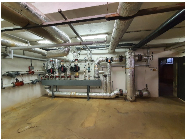
Foto 9 - hydraulický vyrovnávač s napojením sdruženého rozdělovače a sběrače
