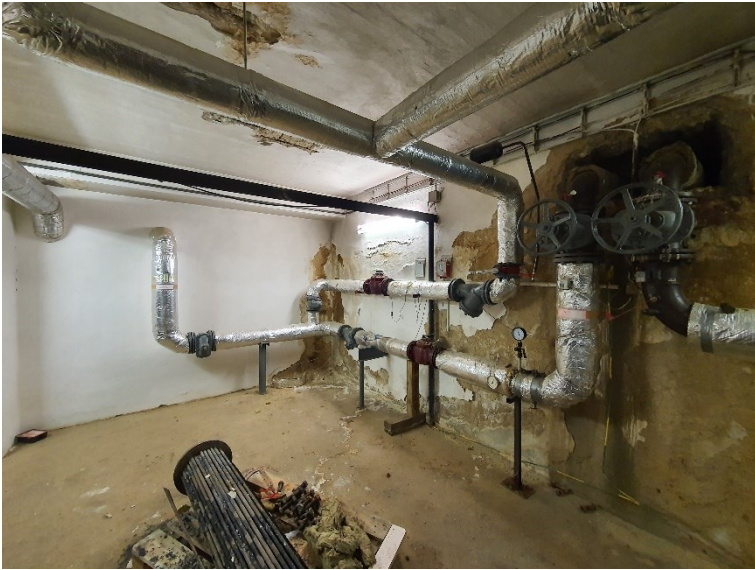
Foto 7 - vstup propoje 2x DN150i70 do objektu VS Palackého
