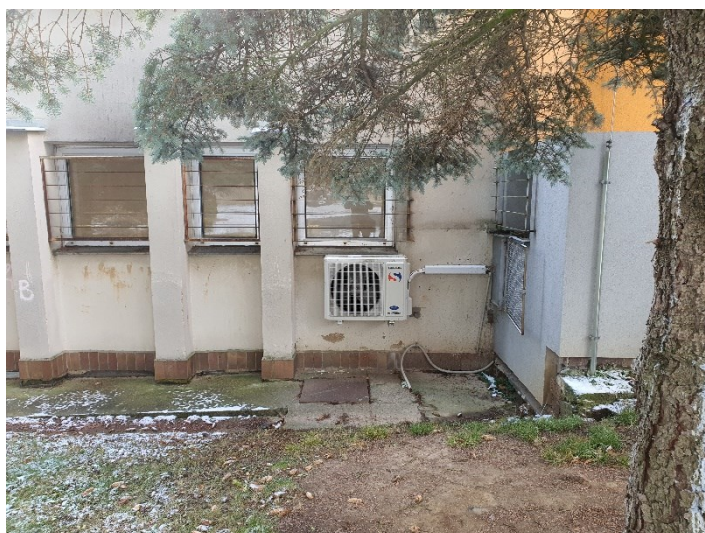
Foto 20 - připojovací šachta teplovodní přípojky pro objekt POTRAVINY – COOP
