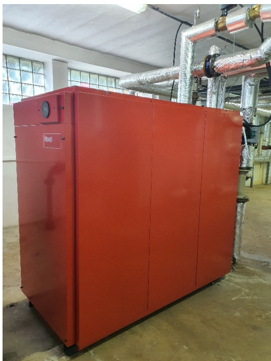
Foto 10 - zásobníkový ohřivač ve VS Palackého
