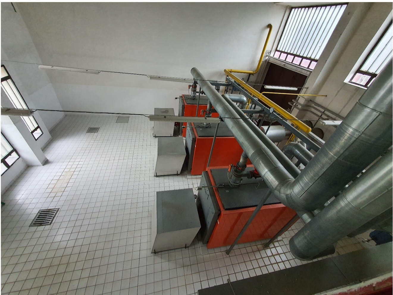
Foto 2 - umístění trojice kotlů
