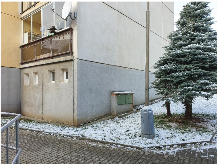
Foto 18 - větrací komínek teplovodní přípojky výstupu z Kozinova 233
