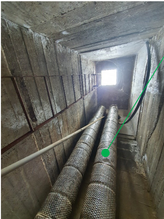
Foto 12 - šachta propoje NTK Kovařovicova – VS Palackého, kde potrubí klesá a podchází silnici Kozinova
