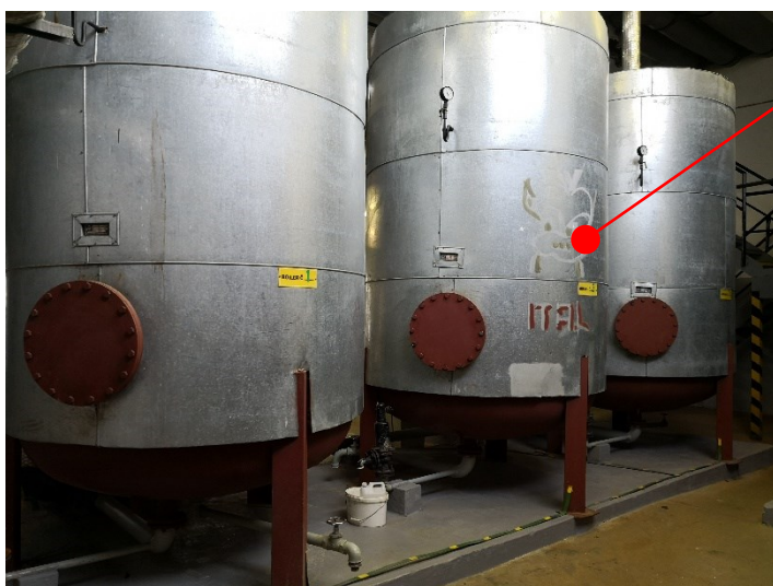
Foto 5 - trojice zásobníků pro okrsek kotelný NTK Kovařovicova
