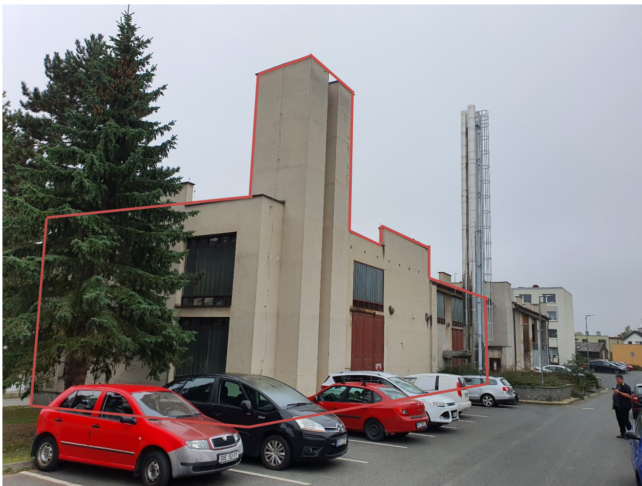
Foto 1 - objekt plynové kotelny
