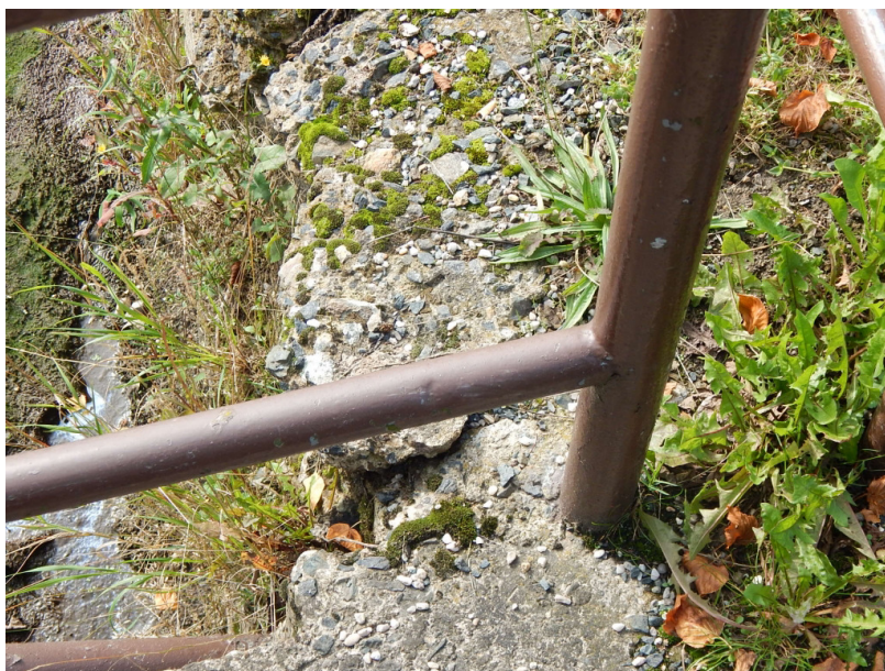
Obr.4-Pohled na kotvení zábradlí do opěr lávky
