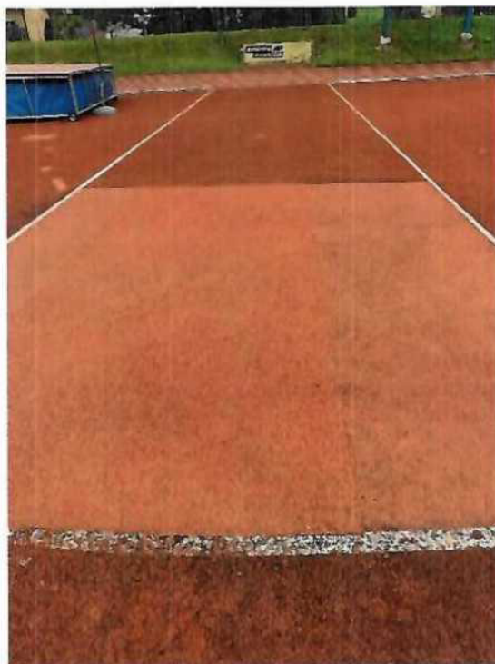
Opravovaná odhodová část rozběhu (různé typy umělého povrchu)
