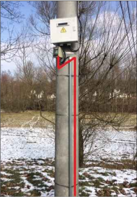
Napájení ze sloupu 230V Rozvaděč pro měření rychlosti
