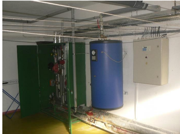
Obrázek 19 - tlakově závislá DPS s ohřevem TV
