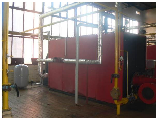
Obrázek 6 - umístění uzavřené expanzní nádoby u kotlů
