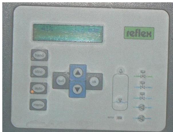
Obrázek 12 - ovládací panel expanzního zařízení
