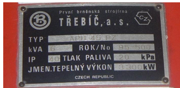
Obrázek 4 - štítek plynového hořáku typ APH 45 PZ s výrobním číslem 500
