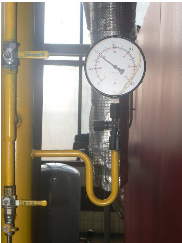
Obrázek 5 - přetlak plynu před hořáky 20kPa
