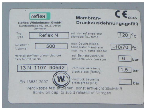
Obrázek 7 - štítek uzavřené expanzní nádoby u kotle
