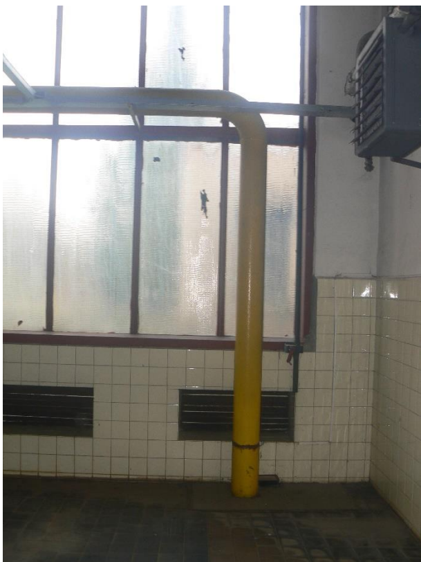
Obrázek 15 - přívod STL plynu do prostoru kotelny
