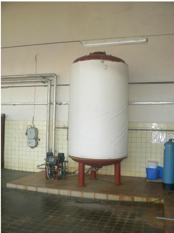
Obrázek 11 - expanzní zařízení s vyrovnávací otevřenou nádobou
