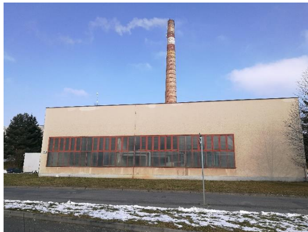
Obrázek 14 - tovární komín výšky cca 37m
