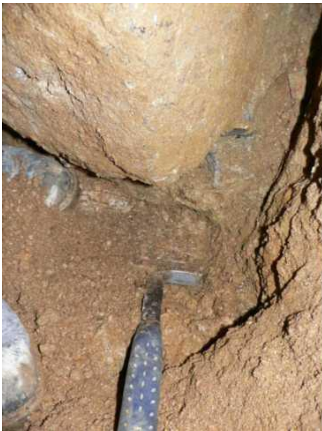
Obrázek S.0.07.3 Kamenná rovinanina pod základem zdi
